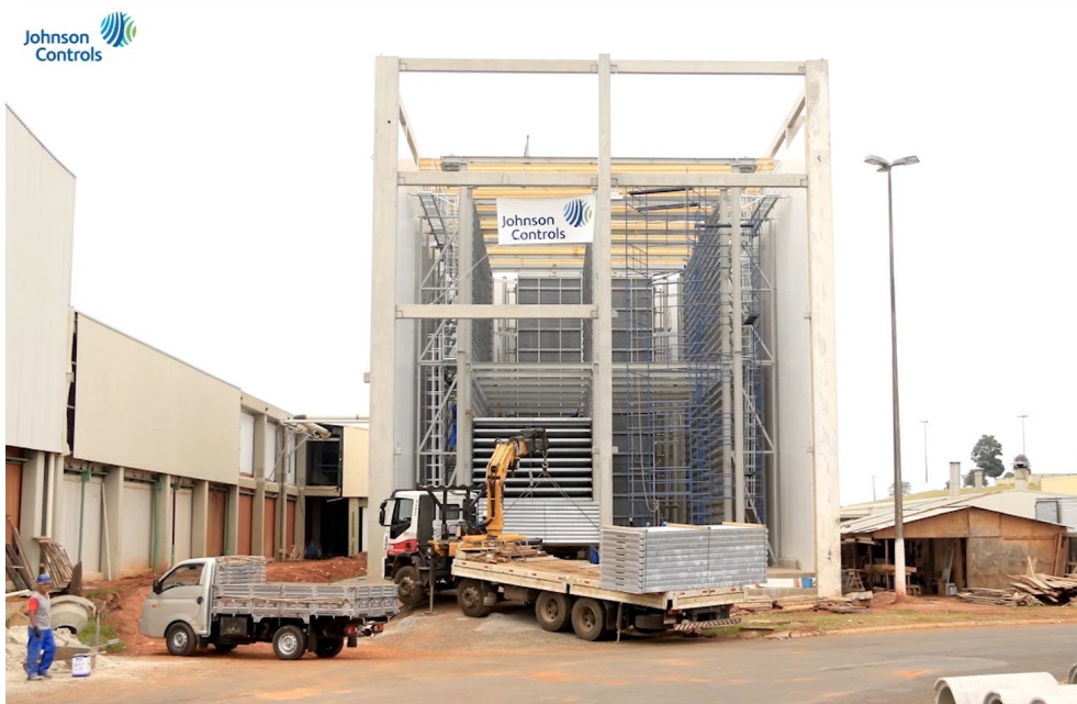
FIGURA 1 – Montagem de um TRV – 2019
